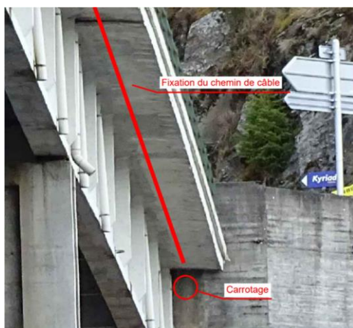
Figure 14 : Principe étudié pour le passage en encorbellement
